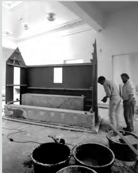
Bjørn Nørgaard, Maison Imaginaire under arbejdet i 1999.
