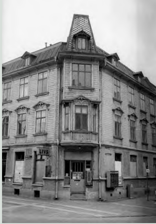
Landshövdingehuset in Olskroken, 1975, Gothenburg.
